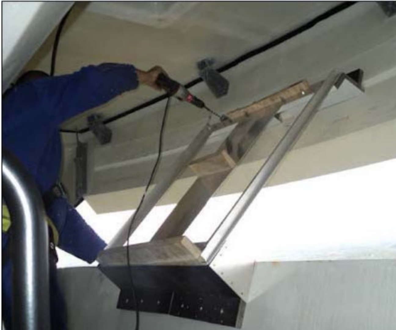
Figur 8 - Montage av plastbitar på turbinblad, vilka plastbitar nog inte tål isbildning, utan faller av.
